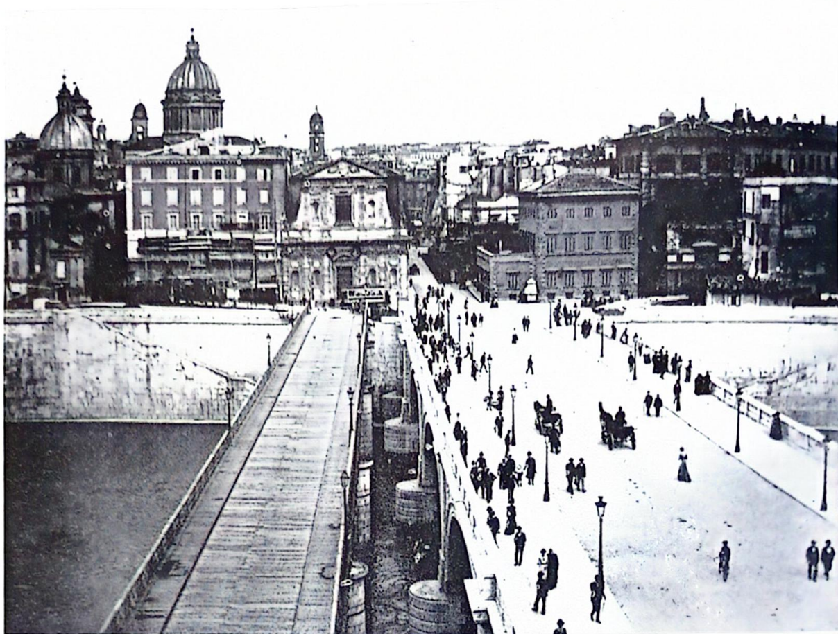
Il nuovo ponte Cavour e il vecchio ponte Ripetta
